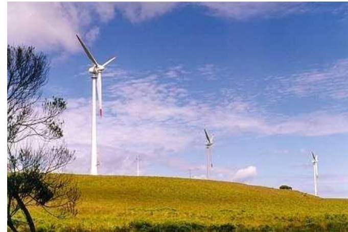
Usina Eólio-Elétrica de Palmas
