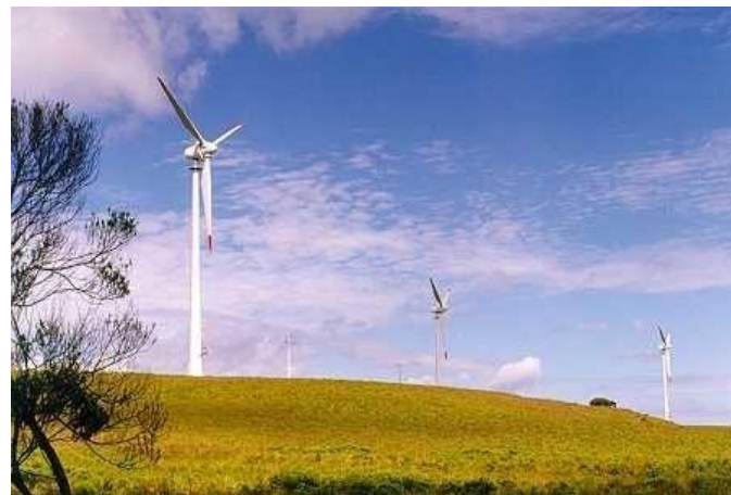
Usina Eólio-Elétrica de Palmas
